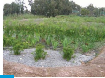
Tel Aviv yakınılarında Yarkon Nehri kenarında kullanılmakta olan yüzey altı akışlı yapay sulak alan (Cieslky, 2006).
