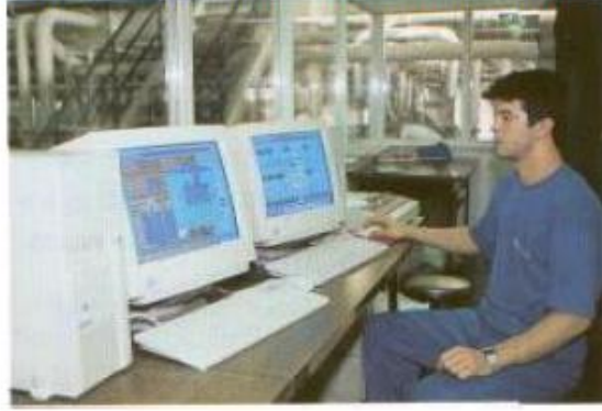
Şekil 1.7: Merkezi kontrol odası
